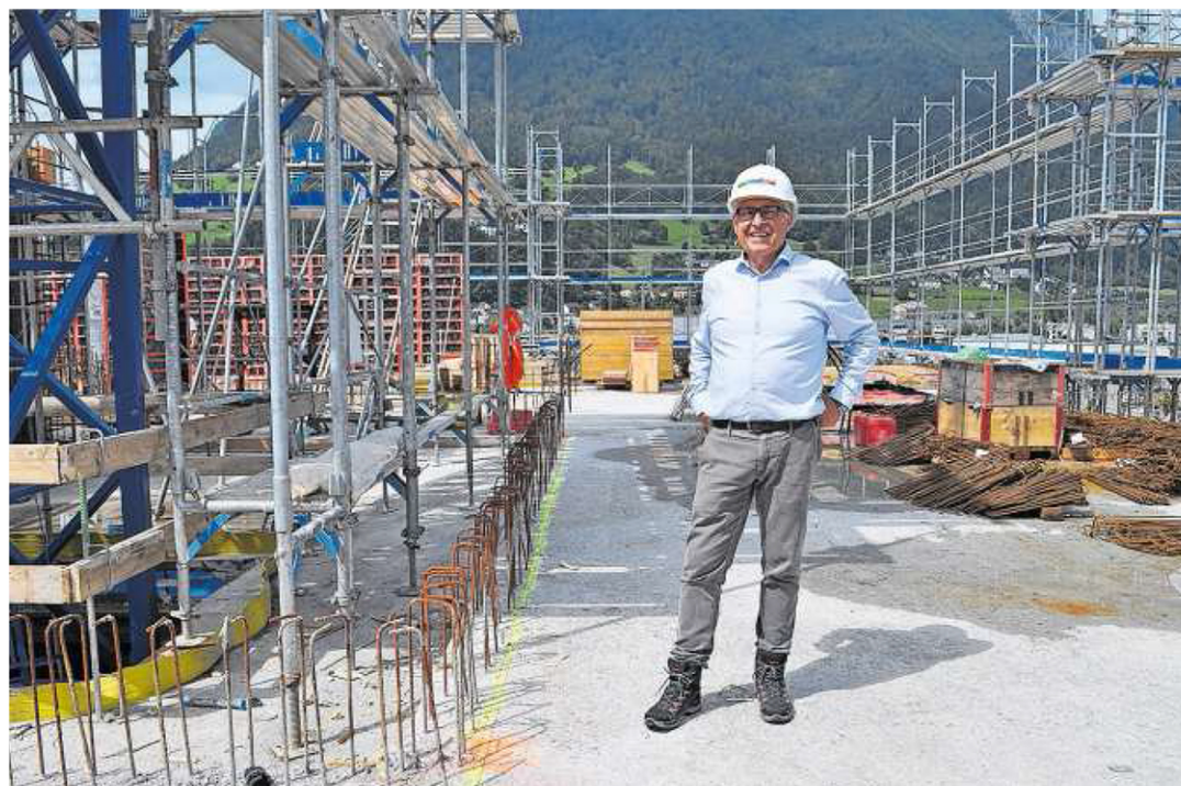
Bauherr Peter von Rotz ist zufrieden mit dem Fortschritt auf der Baustelle.
